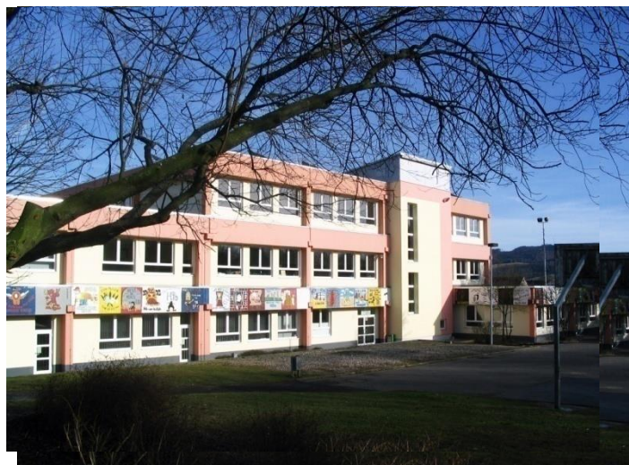
GESAMTSCHULE NIEDERAULA (Schulhofseite)
